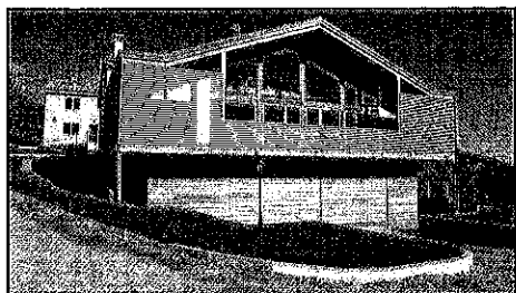
Il nuovo Centro di lavoro guidato di Monfumo.
